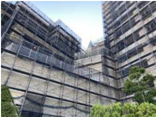
大規模修繕工事は2021年9月～2022年10月に実施
