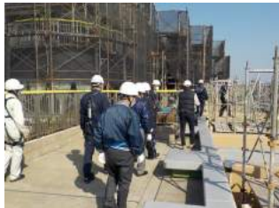
管理組合による現場巡回の様子
