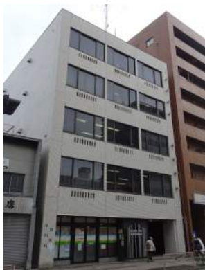
入居する賃貸オフィスビル・サウスライン横浜
