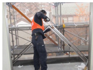
サッシ改修（カバー工法、Low-E複層ガラス採用）
