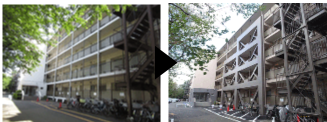
共用廊下外側に外付けフレーム新設
