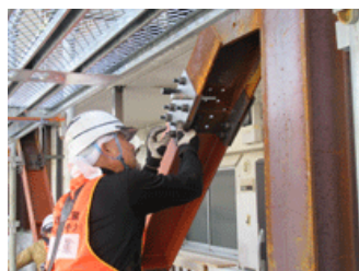
ブレース継手部本締め、継手部のボルト挿入状況
