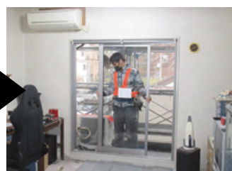
サッシ改修（カバー工法、Low-E複層ガラス採用）
