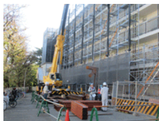
鉄骨材の組み立て状況
