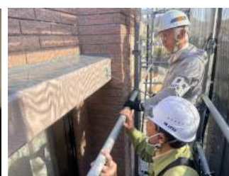
大規模修繕工事中、修繕委員による検査状況
