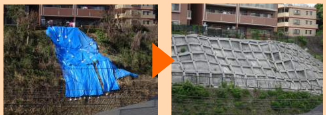
復旧工事で整備された斜面
