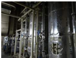
機械室内にあるセントラル給湯設備
