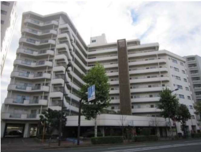
補強後 外観に変化なく耐震化完了
