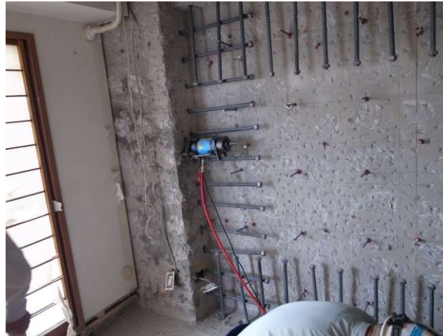
アンカー打込み
