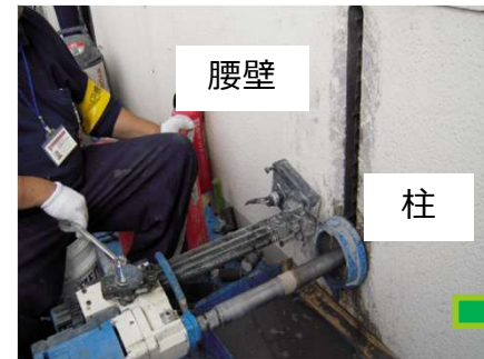
腰壁と柱を切断中
