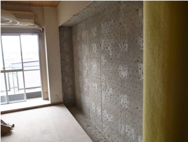
目荒らし工事
