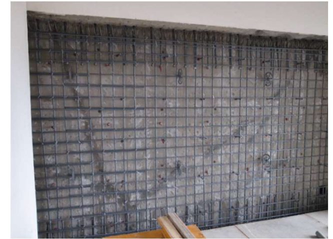
鉄筋組み状況
