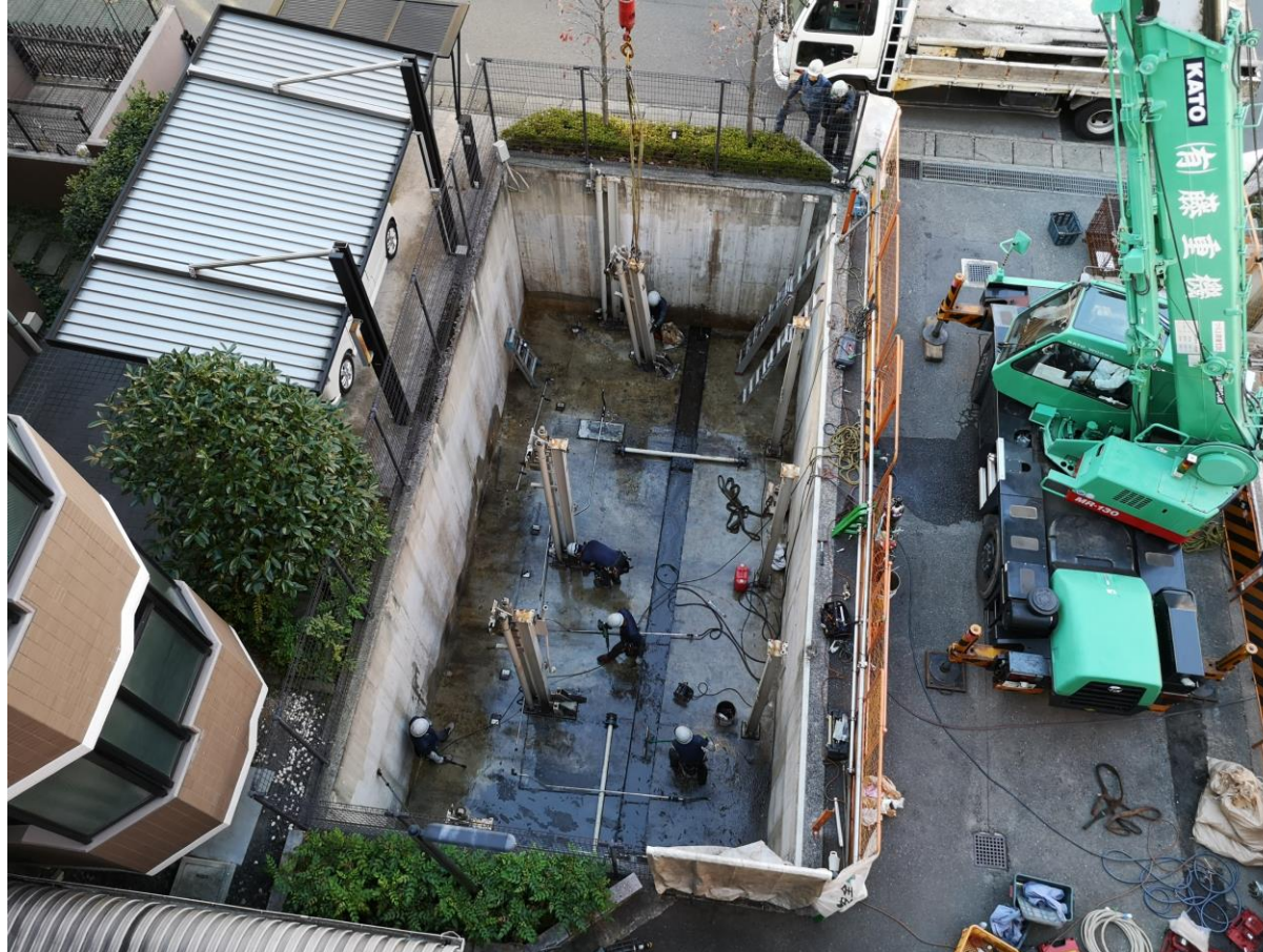
解体中の様子 (写真：管理組合提供)
